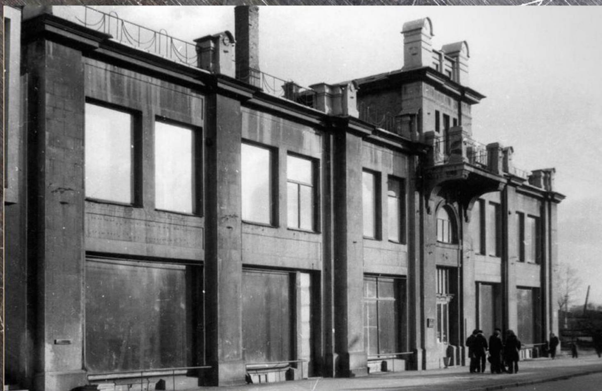
Здание Свердловской картинной галереи на улице Вайнера, 11. 1940-е гг.
