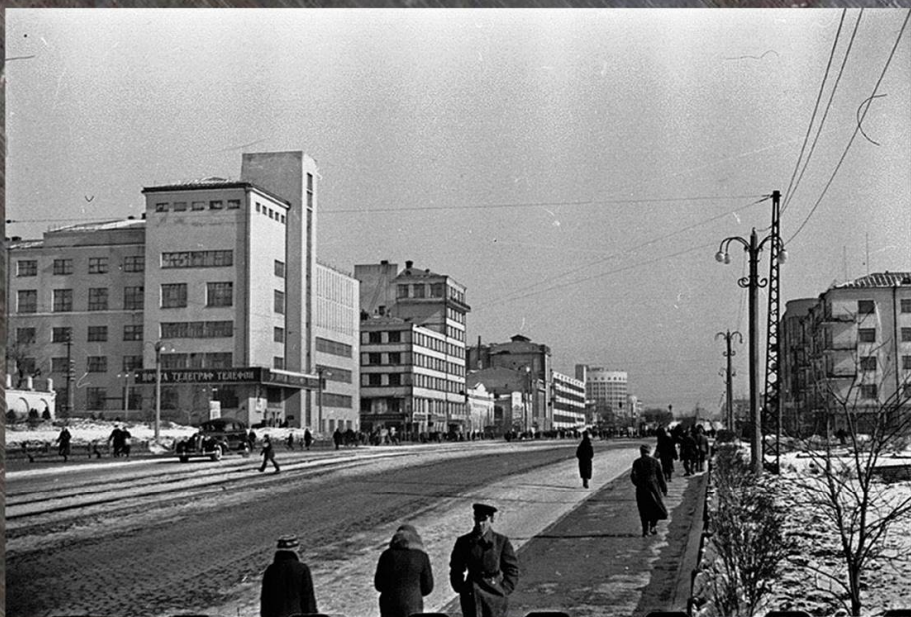
Вид на Центральный телеграф на улице Ленина. 1942 г.
